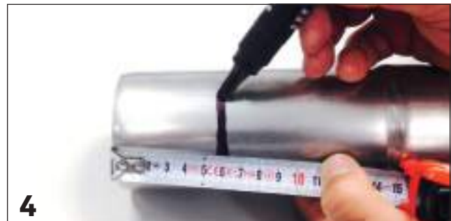
4 Marcatura quota d'innesto / Marking the insertion's depth
