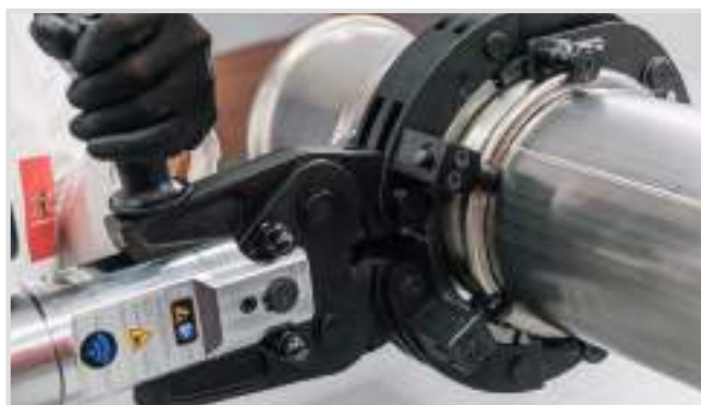
Assemblaggio pressatura n°2 / Press assembly phase 2
